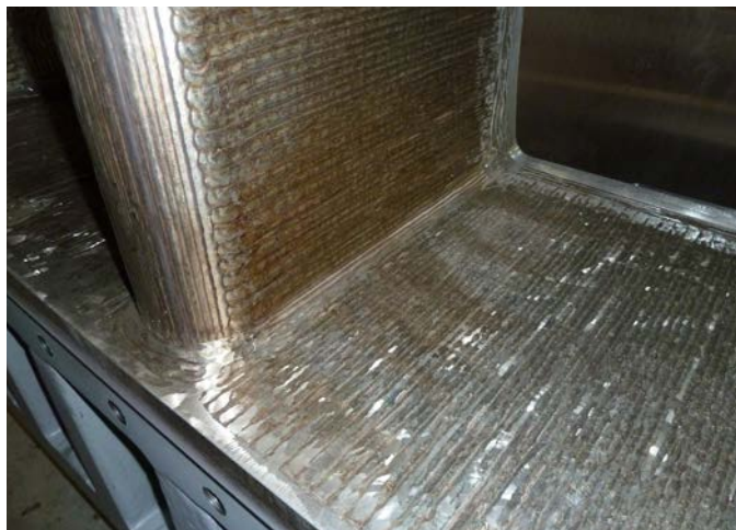
Plaqueado utilizando FOXcore 309L-T1 para una alta calidad superficial, también cuando se suelda en posición.
