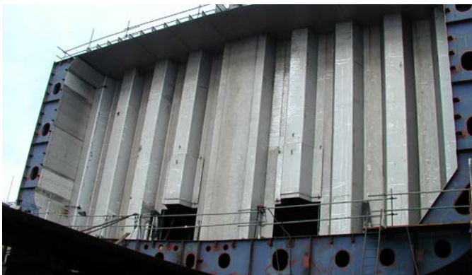
Tanques de carga en un buque cisterna fabricados con 1.4462 y soldados con gas de protección 100% CO 2 . Las soldaduras en posiciones plana y horizontal se han realizado con FOXcore 2209-T0 con respaldo cerámico para la pasada de raíz. Para las soldaduras en posición se ha utilizado FOXcore 2209-T1. Para las soldaduras disimilares se utiliza FOXcore 309L-T0 DG y FOXcore 309L-T1.
